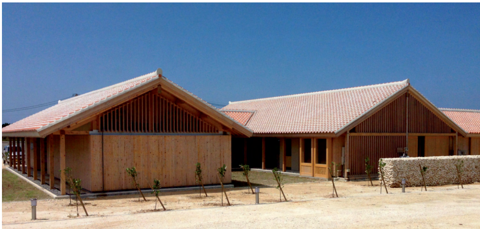
東側外観 分棟による建物構成
